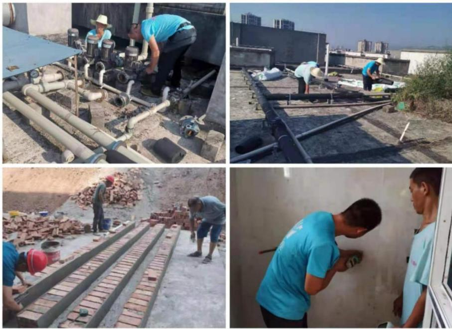
第三周（8.2-8.8）：做好对学生公寓热水系统主管道闸阀、保温层，电磁阀、截止阀等拆除部分进行验收并且完成了淋雨系统的确样工作。
